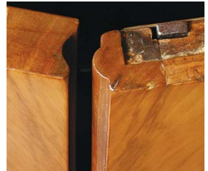
In sich schliessende Türen mit Wulst gegen Hohlkehlprofil, als Hartholzanleimer. Stangenschloss welches auch die Schublade über den Türen verschliesst.
